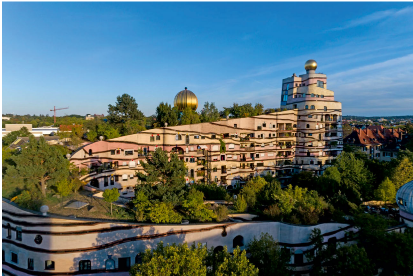
Abb. 5: Friedensreich Hundertwasser/Heinz M. Springmann, Wohnanlage Waldspirale in Darmstadt, 1998–2000
